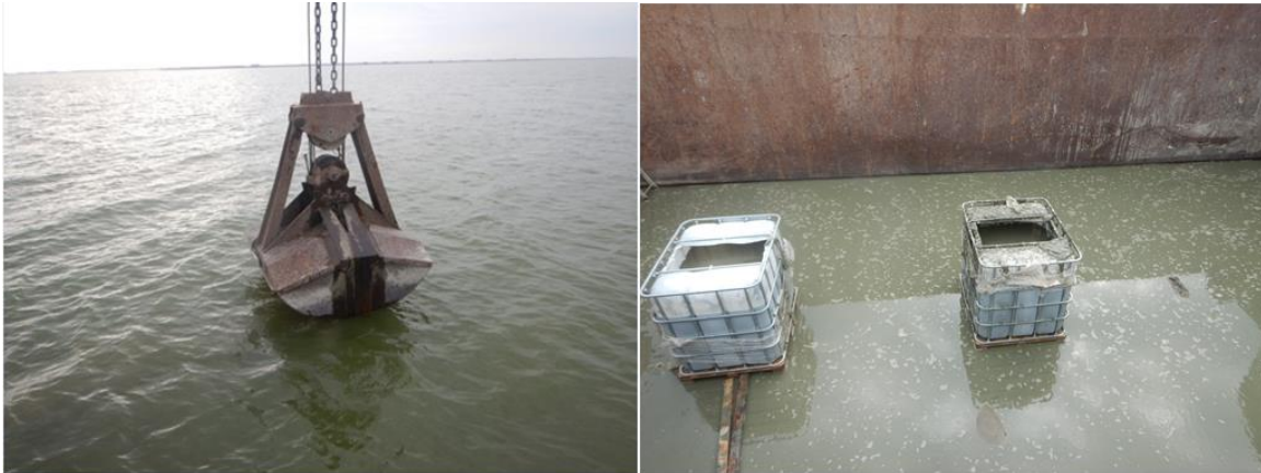
Afbeelding 4.2 Verzamelen van dun slib in dichte bak (links) en opslag in watertanks (rechts)
