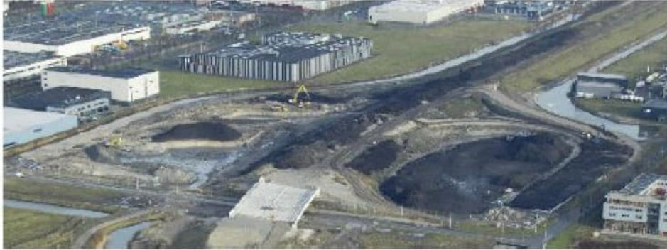
Figuur 3.2 Werkzaamheden aanleg Westrandweg km 13.5, 10 januari 2011 (bron: beeldbank Rijkswaterstaat)
