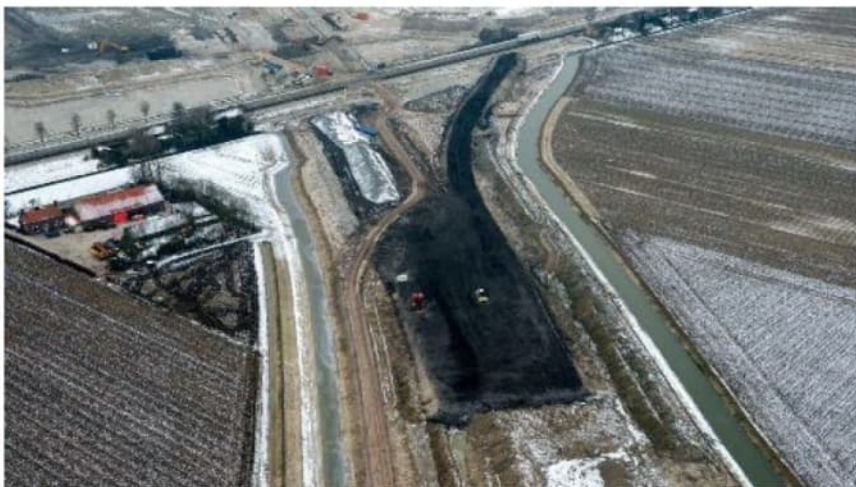
Figuur 2.1 Foto locatie 10: Aanleg A4 12 februari 2013, bron: Rijkswaterstaat
