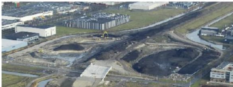
Figuur 3.1 Werkzaamheden aanleg Westrandweg km 13.5, 10 januari 2011 (bron: beeldbank Rijkswaterstaat)
