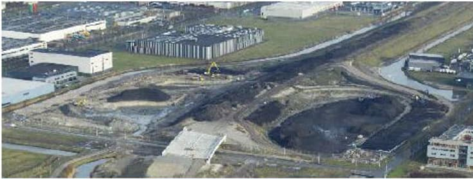
Figuur 3.1 Werkzaamheden aanleg Westrandweg km 13.5, 10 januari 2011 (bron: beeldbank Rijkswaterstaat)
