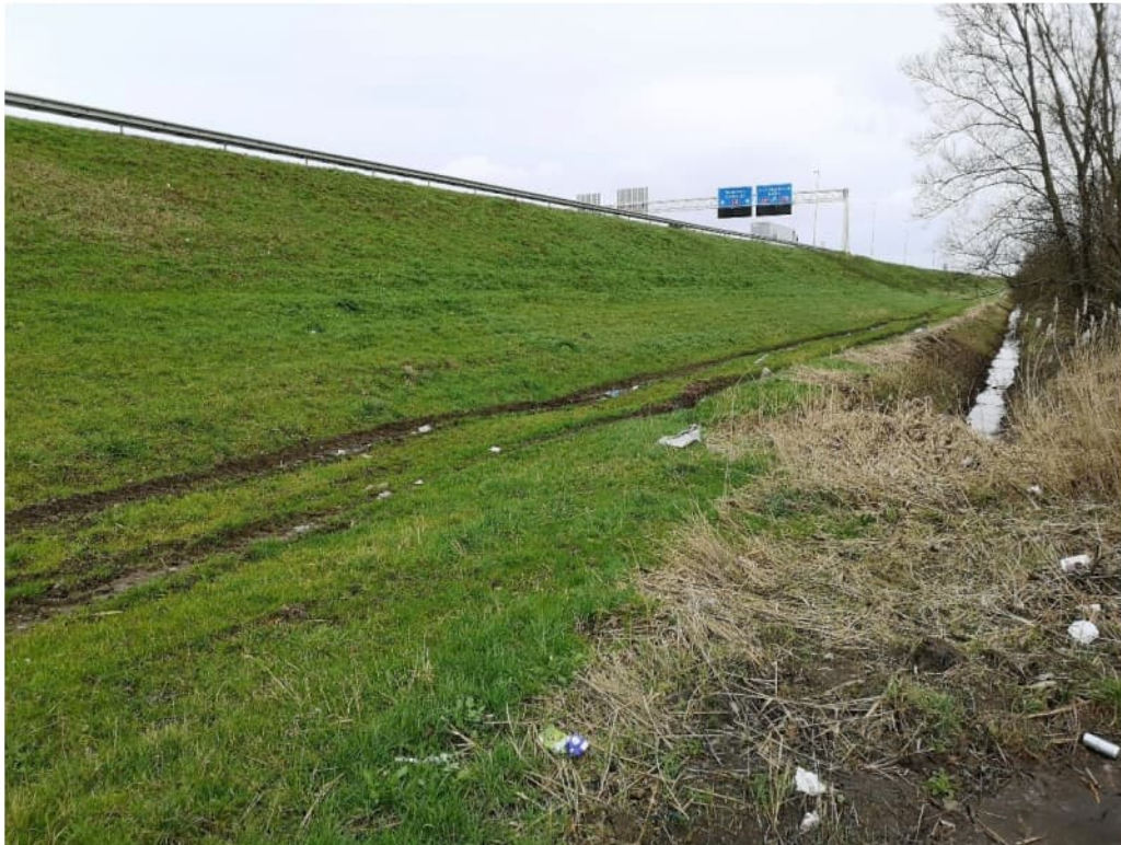
Inspectiepad lang de A16 bij Klaverpolder met rechts de berm-sloot.
