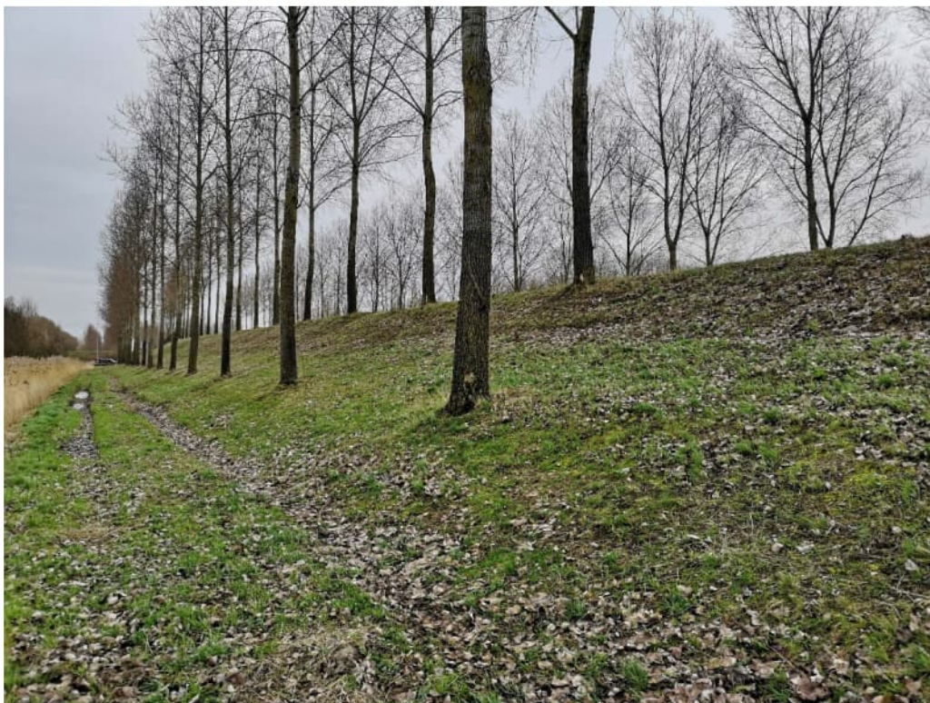
In de Binnenmoerdijksebaan (provinciale weg) is zeer waarschijnlijk TGG toegepast in het weglichaam.
