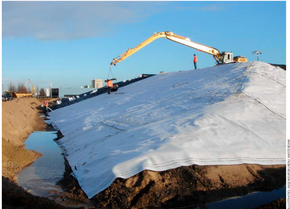
Aanbrengen van folie voor het afdekken van de avi-bodem-as.
