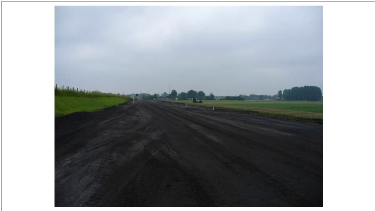
Figuur 1: Toepassen van thermisch gereinigde grond in Westdijk.
