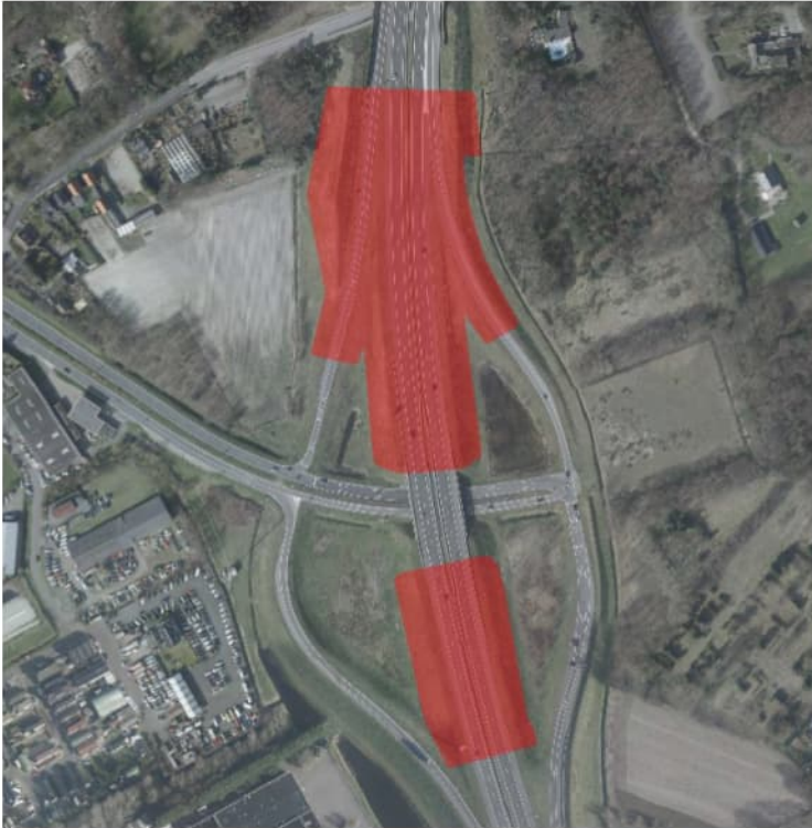
Figuur 4.3 Luchtfoto 2017 (bron: Globespotter), locatie 9.1: A4, aansluiting op de Randweg Oost / N286 in Bergen op Zoom. In rood de toepassing van TGG.
