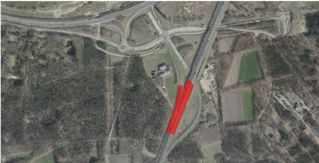
Figuur 4.7 Luchtfoto 2017 (bron: Globespotter), Knooppunt Paalgraven. In rood de toepassing van TGG.
