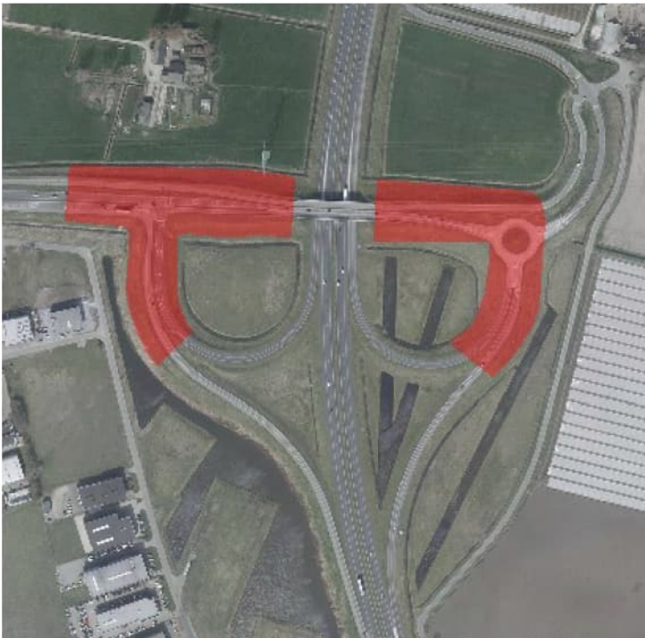
Figuur 4.4 Luchtfoto 2017 (bron: Globespotter), locatie 9.2: A4, aansluiting op de Randweg Oost / N286 in Halsteren. In rood de mogelijke toepassing van TGG.
