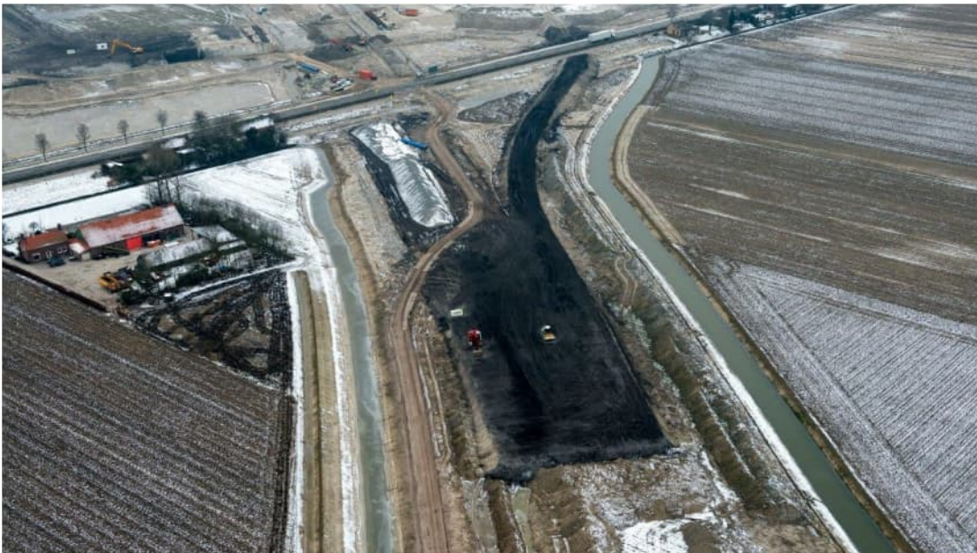
Figuur 4.5 Foto locatie 10: Aanleg A4 12 februari 2013, bron: Rijkswaterstaat
