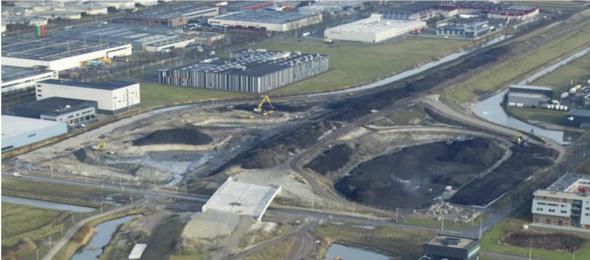
Figuur 4.6 Werkzaamheden aanleg Westrandweg km 13.5, 10 januari 2011 (bron: beeldbank Rijkswaterstaat)
