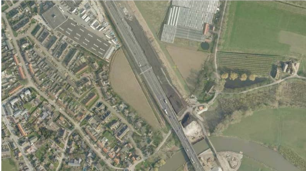
Figuur 4.2 Luchtfoto 2008 (bron: Globespotter), A2 aanleg brug over de Linge
