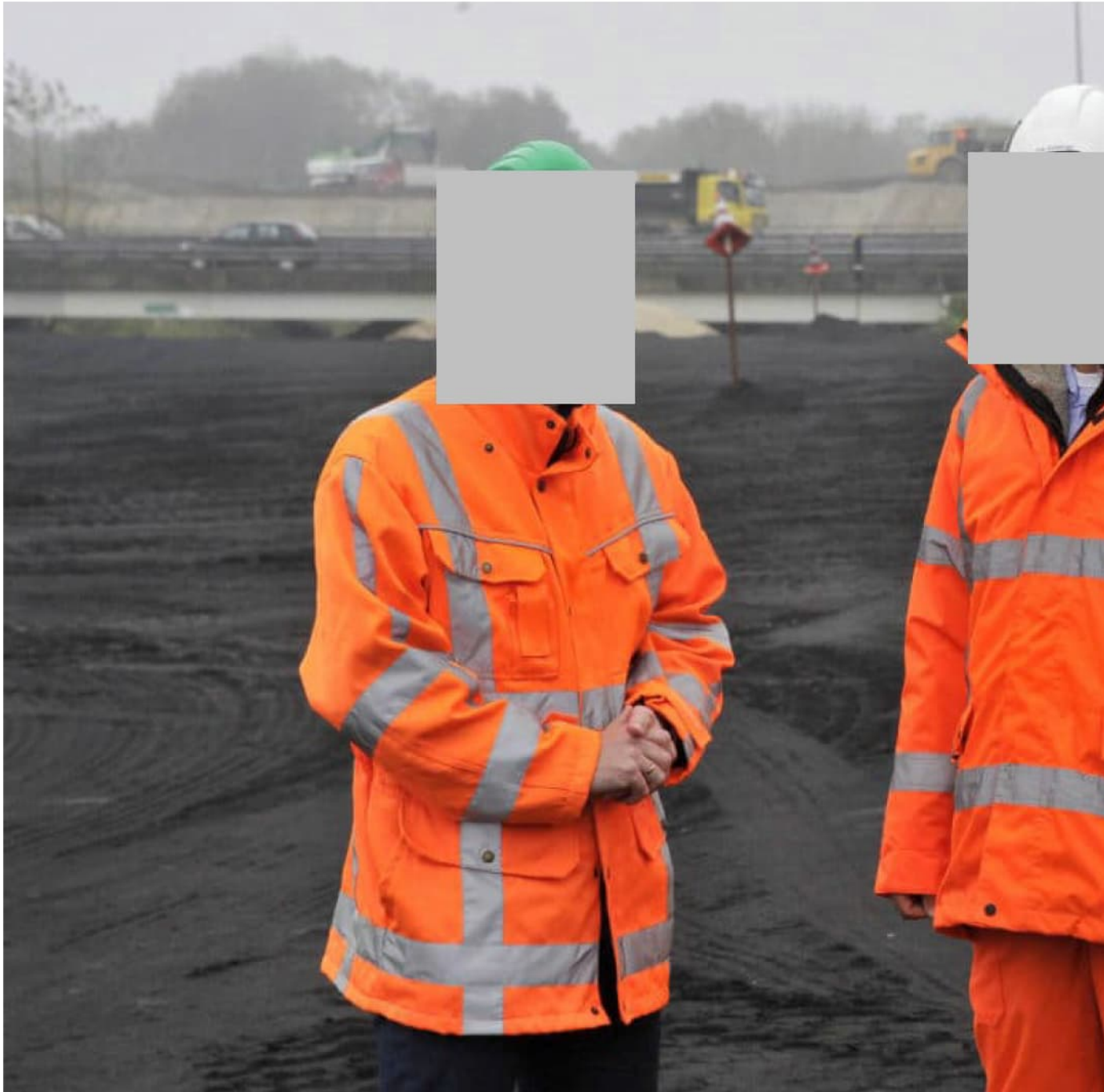
Projectdirecteur [redacted] (rechts) van Parkway6 en technisch manager Johan de Wit van Rijkswaterstaat op de bouwplaats van ecozand in de wegenbouw. (Foto: [redacted])
