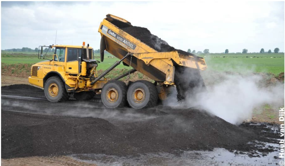
Figuur 2.3 Aanbrengen van TGG in het project Overdiepe polder. Het materiaal lijkt nog warm
