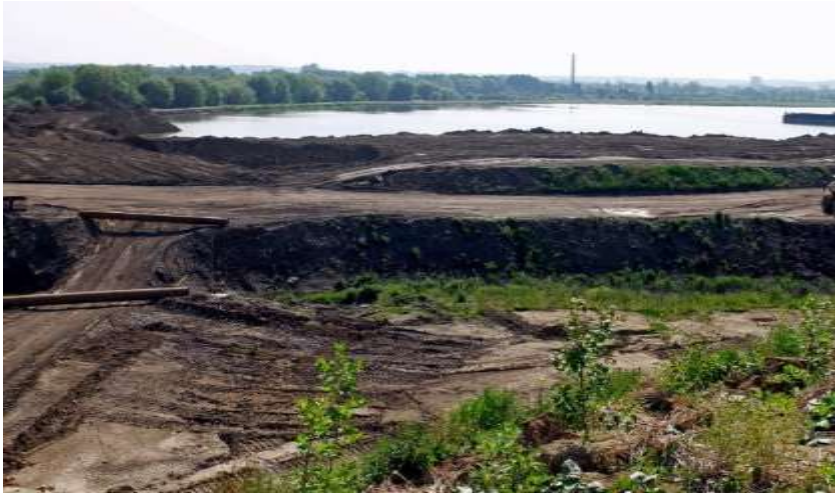
Figuur 5-5: Graafwerkzaamheden bij Bosscherveld.
