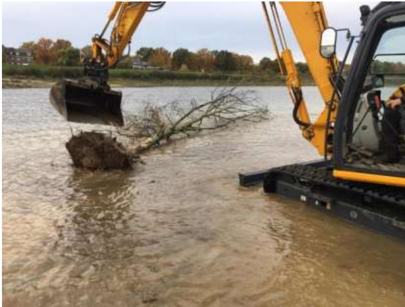
Figuur 7-10: Aanbrengen rivierhout in de Grensmaas in 2019 (foto: J-J. Bakhuizen)
