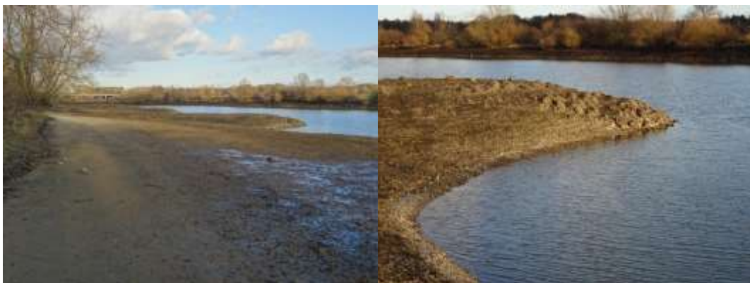
Figuur 7-2: Drooggevallen Maasoevers in de Oude Maasarm bij Heijen in januari 2017. Het waterpeil in het stuwpand was toen sterk gereduceerd door schade aan de stuw van Grave. Op het harde substraat vond massale sterfte van mosselen plaats. (foto's: T. Violier, RWS ZN)
