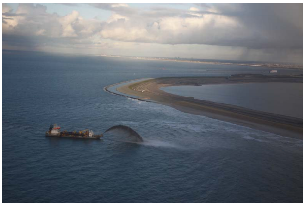
Aanleg Tweede Maasvlakte, november 2012. ( Pim Wolf )
