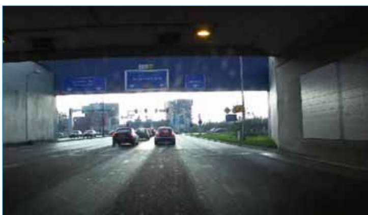
VRI Noordelijke Randweg/ Noordtunnel (uitgang Parktunnel)
