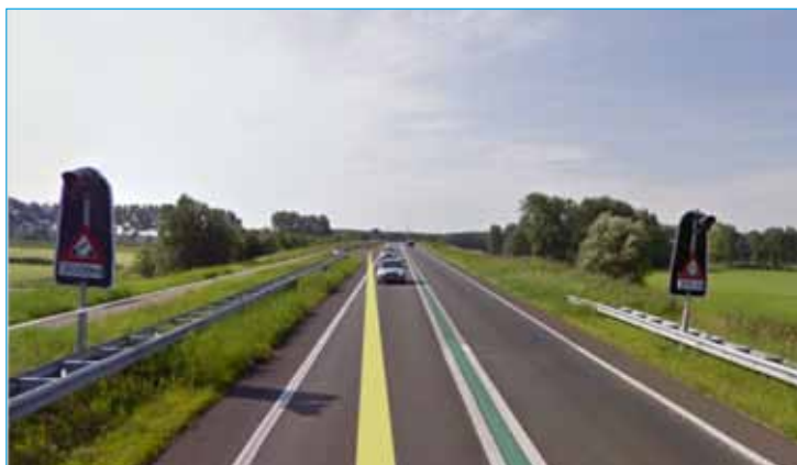
Zicht op brug komende vanuit noordelijke richting (brug niet zichtbaar).
