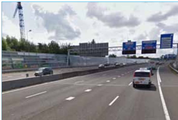
Eerste bewegwijzering staat na start blokmarkering, eerste bewegwijzering zou eerder aangegeven moeten worden.
