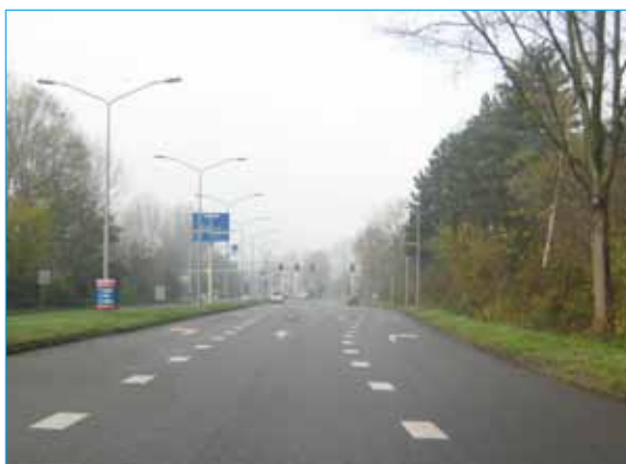
Kruispunt gezien vanaf de Bergerweg (vanuit Bergen). Iedere richting heeft een apart opstelvak.
