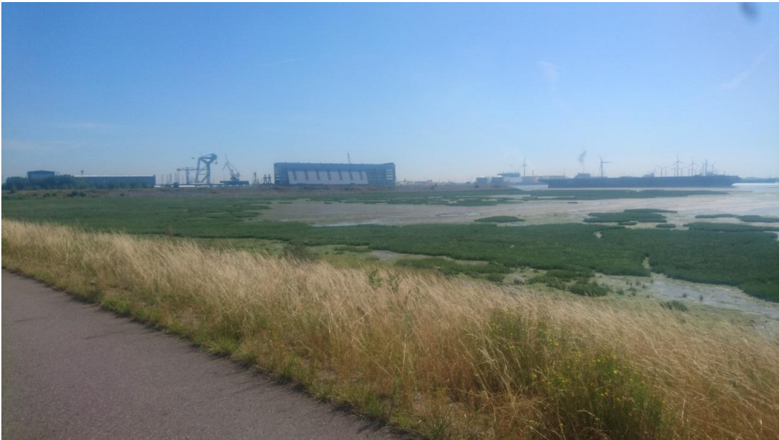
Foto 42: Sloehaven, Overzichtsfoto, Oost-zuidoostelijke richting
