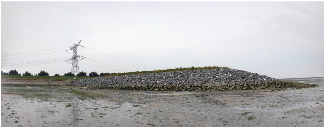
Foto 36: Zuid-Beveland, Opgeworpen stenen dam
