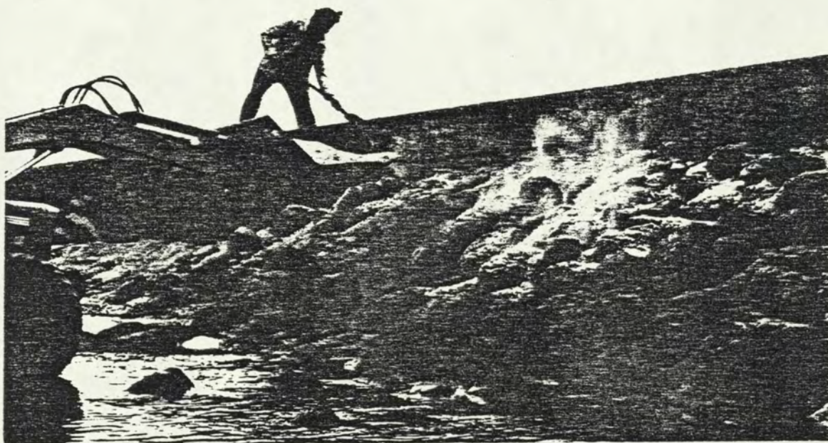
Foto 5 Het afstrooien van de olie die op harde zeegeving terecht is gekomen met zand versneld de reiniging aanzienlijk.
