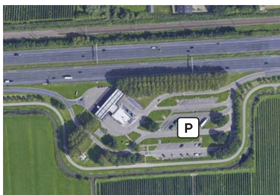
Bestaande verzorgingsplaats met parallelspoor (enkelzijdig)
