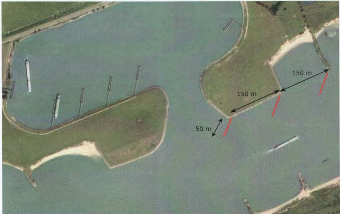
Figuur 6-10 Locatie zandspiraalbuizen bij haven Haaften
