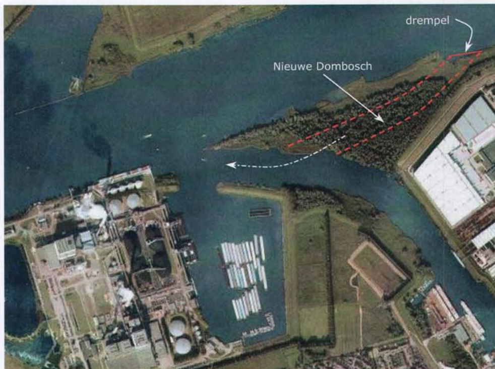
Figuur 4-6 Aanleg nevengeul
