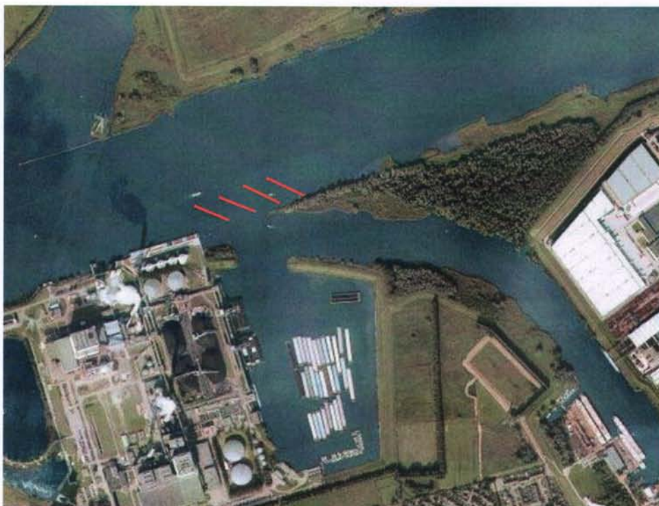
Figuur 4-7 Aanleg zandspiraalbuizen
