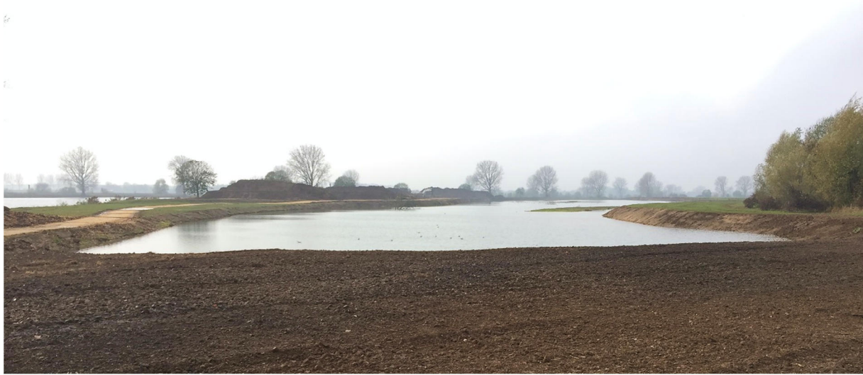
Figuur 28 De hoogwatergeul Maasbommel tijdens de eindfase van de inrichting in november 2016.
