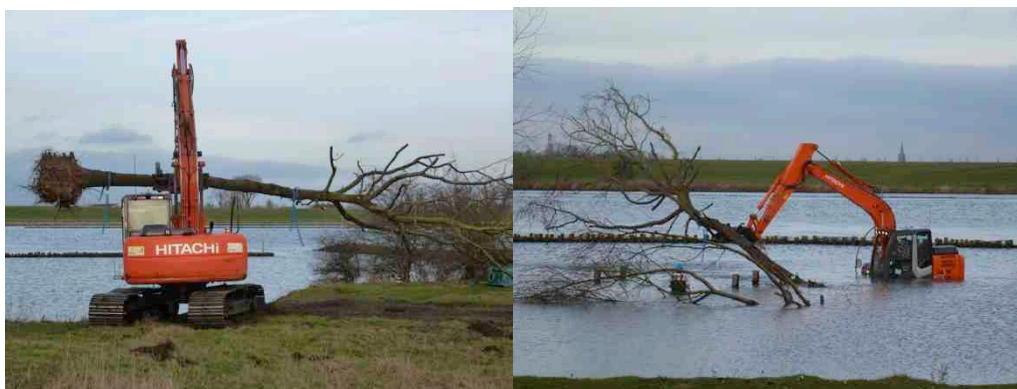
Foto 2.1 Het aanbrengen van bomen in een kribvak langs de Lek nabij Everdingen in januari 2014.
