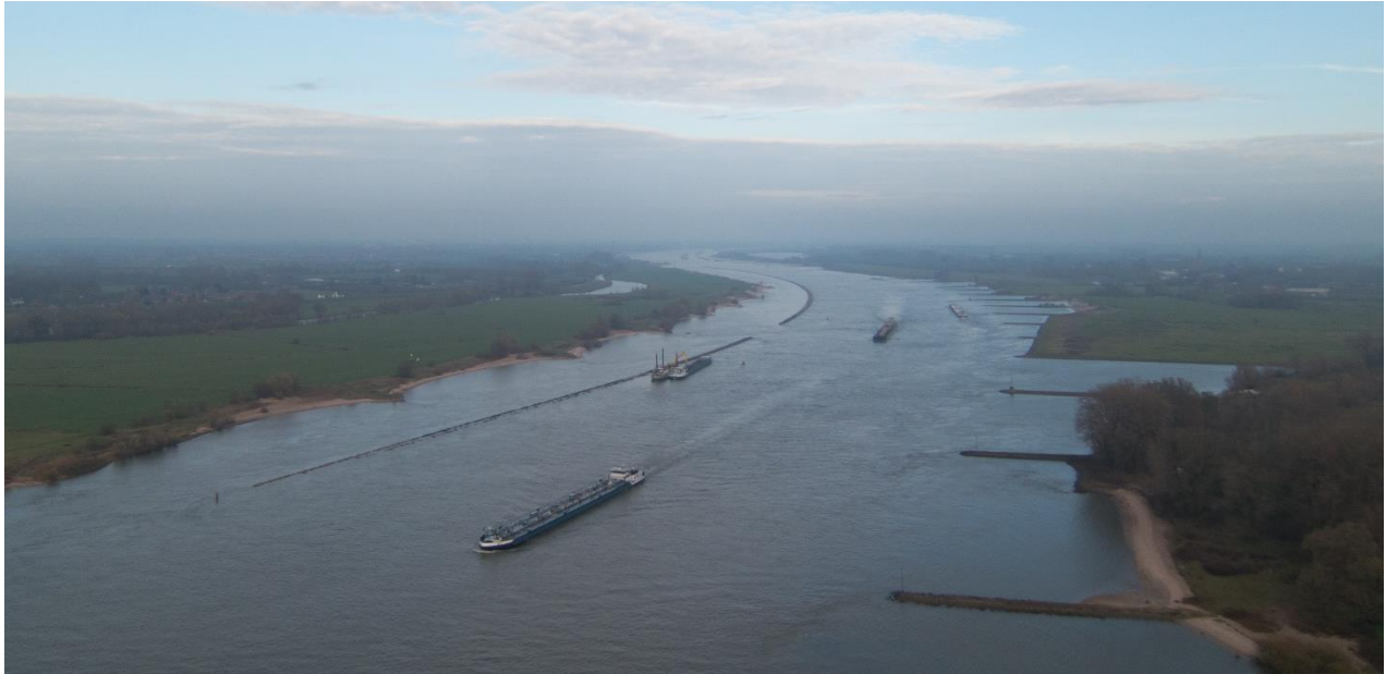
Figuur 1-1 Luchtfoto van de langsdammen (bron: beeldbank.rws.nl)
