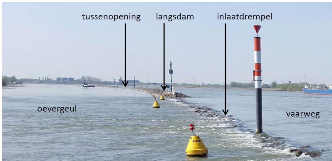
Afbeelding 3.2 Langsdam bij Wamel, met vaarweg, oevergeul, (de in 2018 verhoogde) inlaatdrempel en tussenopening
