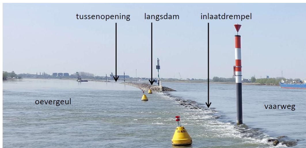
Figuur 1-2. Langsdam bij Wamel, met vaarweg, oevergeul, inlaatdempel en tussenopening.
