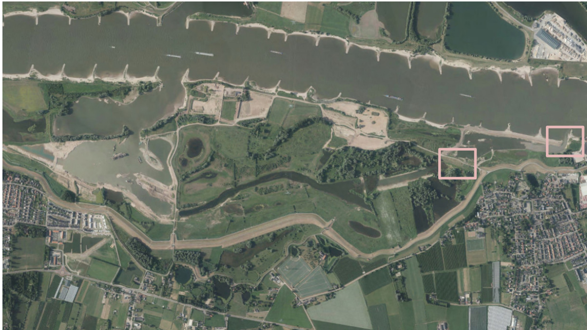
Figuur 2.2. De nevengeul van de Afferdense en Deestse Waarden in aanleg (bron: ESRI Nederland, beeldmateriaal.nl). Het linker kader betreft de instroom vanaf de zandvang naar de rest van de nevengeul. Het rechter kader is de instroomopening vanaf de Waal naar de zandvang.
