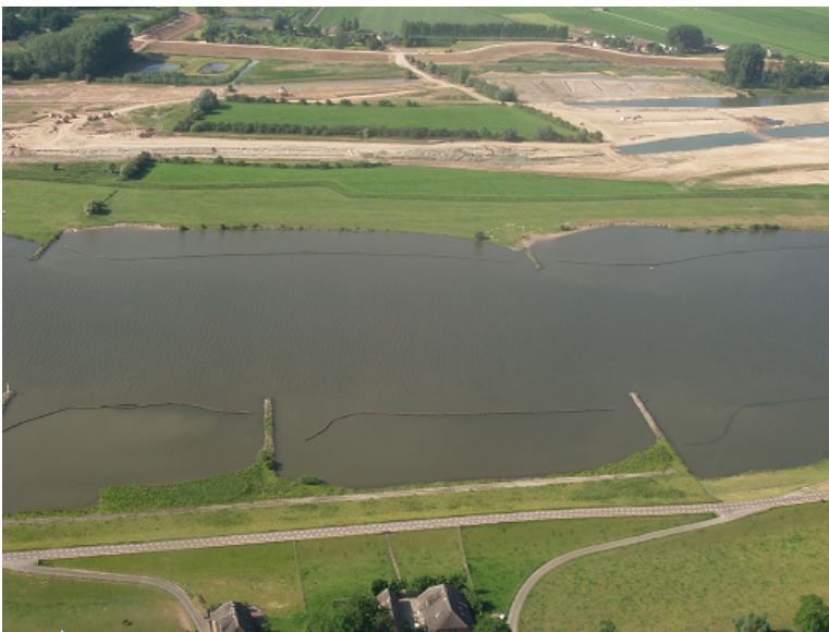
De vooroevers vanuit de lucht vanaf de noordzijde. (foto: Rijkswaterstaat)
