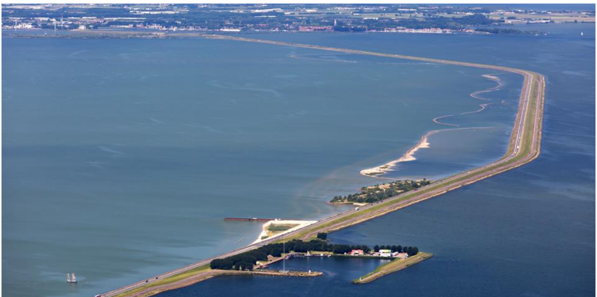
Figuur 1.1. Het noordelijke deel van de Houtribdijk met Enkhuizen op de achtergrond en de Trintelhaven op de voorgrond in 2017. Direct achter de haven, aan de westzijde van de dijk is het proefproject te zien, met de rood gekleurde, ver uitstekende strekdam (foto: Gerhard van Roon, Rijkswaterstaat).
