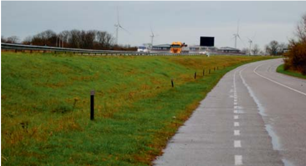
Foto 3: wildreflectoren langs de parallelweg op de Veerse Gatdam
