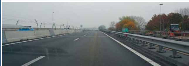
T.h.v. de brug is geen vluchtstrook aanwezig en versmalt het wegbeeld.
