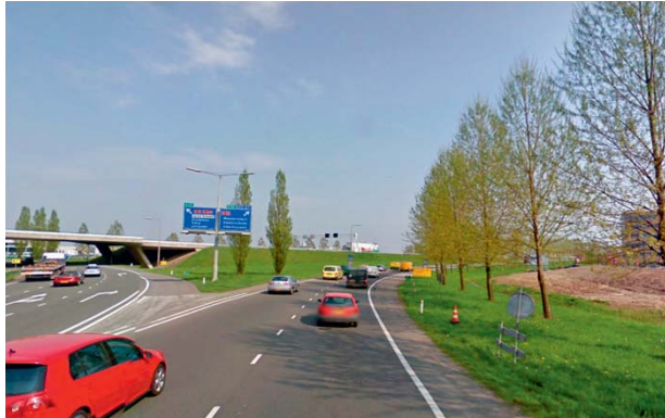
Foto 2: Knooppunt Velperbroek ter hoogte van de toerit richting Westervoort/Duiven (oude situatie)
