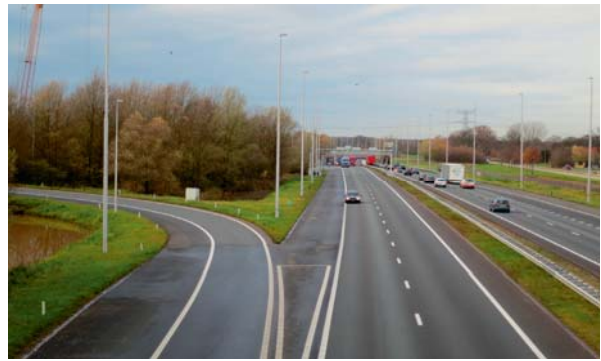
Foto 2: aan weerszijden van de toerit liggen onafgeschermd waterpartijen
