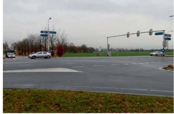
Foto 2: Kruispunt N35-Dalfserweg met geleidende diagonale markering
