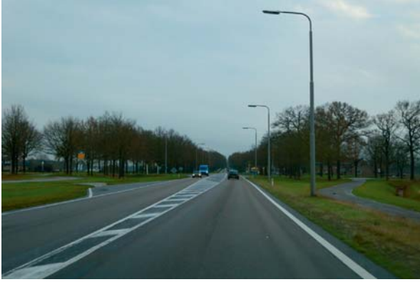
Foto 1: kruispunt N35-Hagenweg met op de achtergrond het viaduct over het Overijsselskanaal
