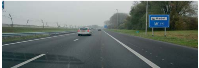
Verder stroomafwaarts eindigt de geleiderail. De obstakelvrije zone is voldoende breed.
