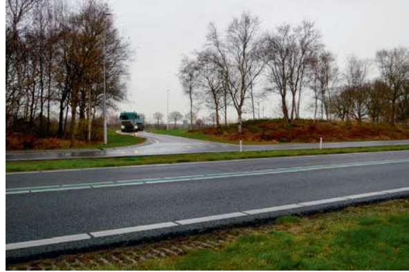
Foto 2: aarden wal en begroeiing op verzorgingsplaats Hazepad beperken het zicht voor verkeer vanaf de parkeerplaats
