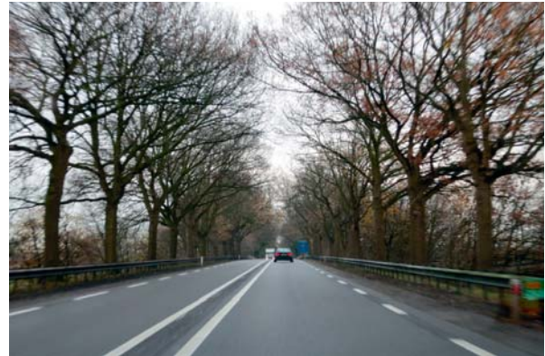
Foto 4: N35 tussen de kruispunten Bos en Veldhoen ter hoogte van het viaduct over het kanaal
