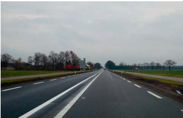
Foto 5: N35 tussen Mariënheem en Nijverdal met nieuwe deklaag en bermverharding
