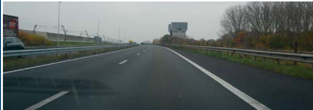
Stroomopwaarts van de brug over het Amterdam-Rijnkanaal is een vluchtstrook aanwezig.
