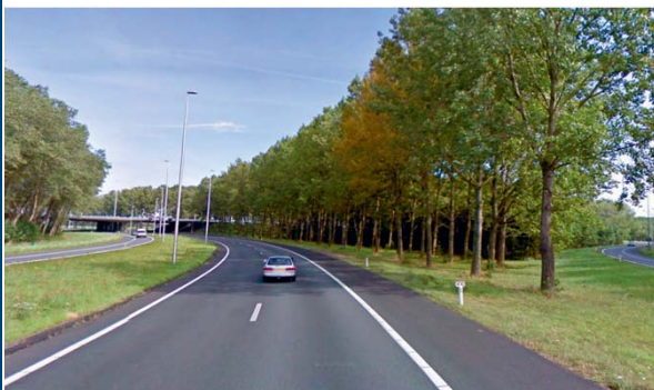
Foto 7: A73, verbindingsweg e ter hoogte van knooppunt Neerbosch
