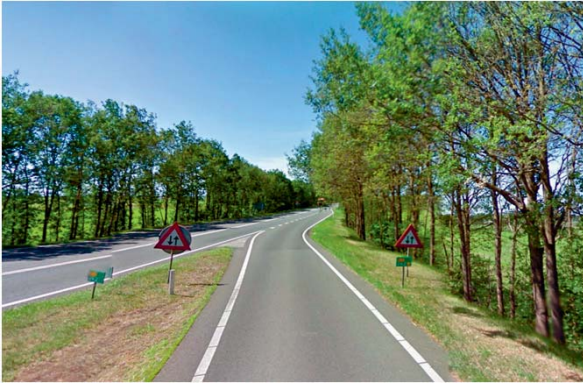
Foto 3: korte invoegstrook met korte, krappe bocht bij toerit Beerzerveld (bron: Google Streetview)
