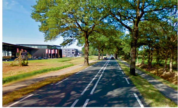
Foto 2: N35 tussen Nijverdal en de Burg. Boersingel met aan weerszijden van de rijbaan bomen binnen de obstakelvrije zone
