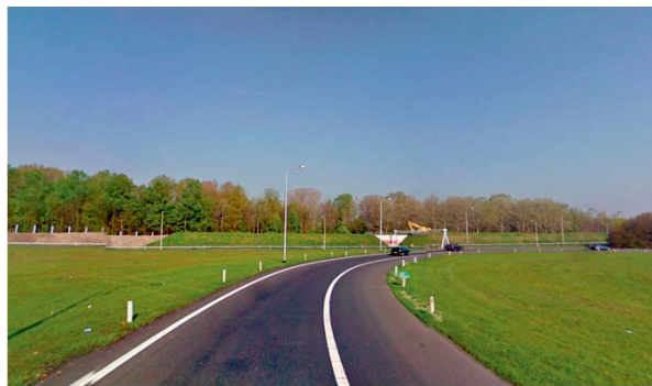
Foto 8: verbindingsweg k in knooppunt Beekbergen met in de buitenberm lichtmasten
