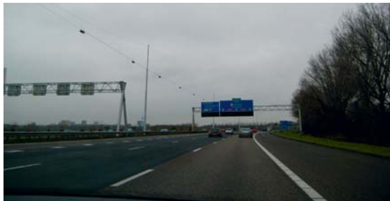
A2 HRL - ten zuiden van knooppunt Amstel, splitsing naar A'dam Centrum, A10 HRL en A10 HRR
