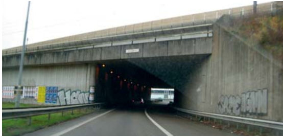
Toerit S111, na samenvoeging van 2 naar 1 rijstrook en TDI rijdt verkeer onder spoorviaduct door ('blokkendoos').
