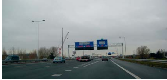
Vanaf de toerit van de S111 rijdt verkeer door over het weefvak dat over gaat in de verbindingsweg naar de A2. Deze is vormgegeven als een taper, waarbij het weefvak overgaat in de rechtterijstrook van de HR).
