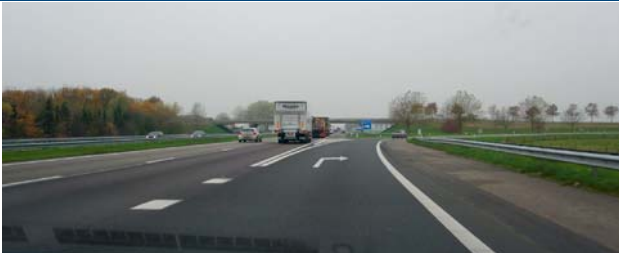
Naast de uitvoegstrook loopt de vluchtstrook door. Kort na het puntstuk ligt een krappe boog.
