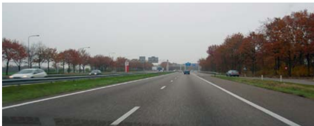
De korte toerit vanaf verzorgingsplaats Wouwe Tol-Zuid die overgaat in een weefvak.
