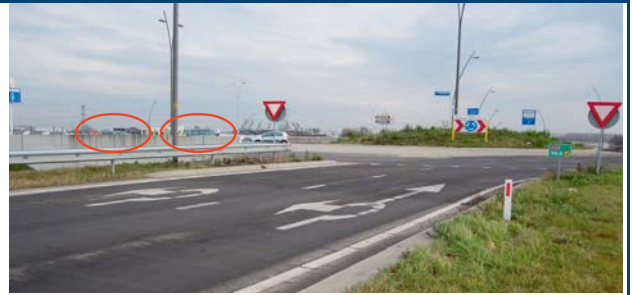
Personenauto's op de rotonde vallen weg achter de betonnen wand. De B6-verkeersborden (voorrang verlenen) vallen minder goed op door verstorende verkeersborden en reclame-uitingen in de nabije omgeving.
