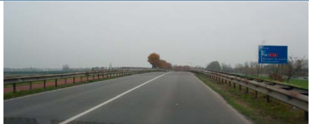
Op de Plantagebaan vanuit zuidelijke richting belemmert het viaduct het zicht op de toe-/afrit.
