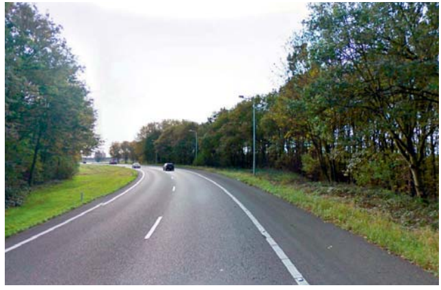
Verbindingsboog knooppunt de Stok, advies: plaatsen geleiderail
