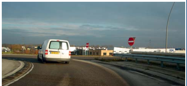
Taluds naast de rotonde zijn niet afgeschermd.
