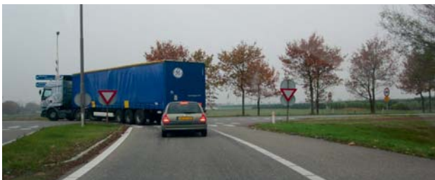
Voorrangskruispunt aan het einde van de afrit met vrijliggende fietspaden in de voorrang.
