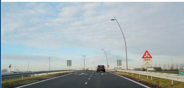
De linkerstrook wordt minder intensief benut aangezien dit een onlogische verkeersstroom betreft. Vanaf de rechter opstelstrook is het zicht op de rotonde beter.
