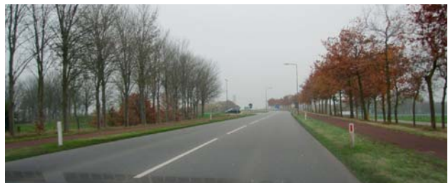
Vanuit noordelijke richting (Plantagebaan) wordt het zicht op de toe-/afrit belemmerd door bomen.
