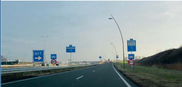
Het verloop van de afrit dwingt geen snelheidsaanpassing af, ondanks het snelheidsregime.
