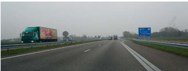
Op de hoofdrijbaan A58 HRL t.h.v. begin afrit. De vluchtstrook loopt door naast de uitvoegstrook.
