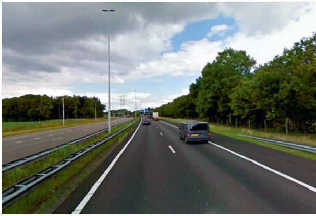
T.p.b. knooppunt de Baars, advies: plaatsen/doortrekken geleiderail
