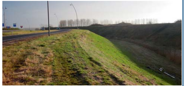
Direct naast de bypass ligt een berm van 6 meter breed met daarnaast een stijl talud.
