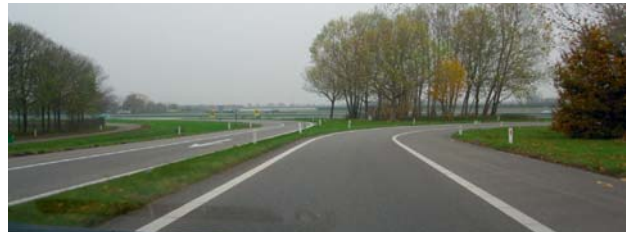
Tussen de toe- en afrit zit geen fysieke middenbermscheiding. De toerit bevat een krappe boog.
