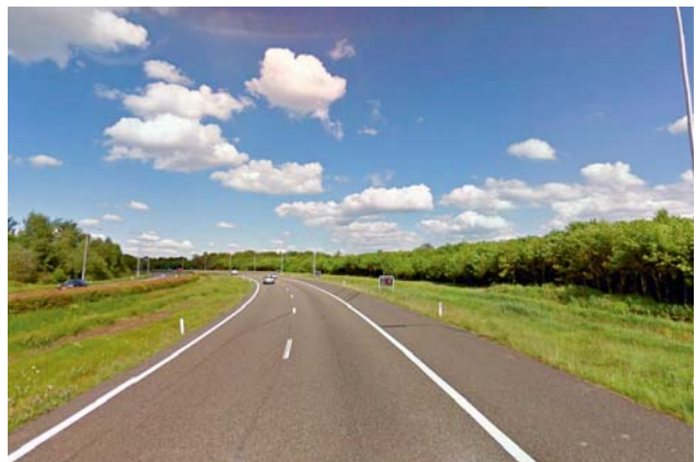
Verbindingsboog knooppunt St. Annabosch, advies: doortrekken geleiderail (obstakelvrije zone voldoet, maatregel is aanvullend)
