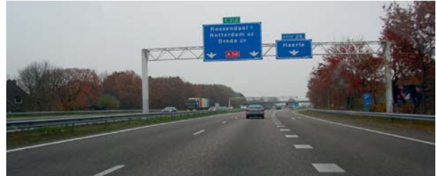
De weefvaklengte tussen verzorgingsplaats Wouwe Tol-Zuid en afrit Heerle (26) is +/- 400 meter.
