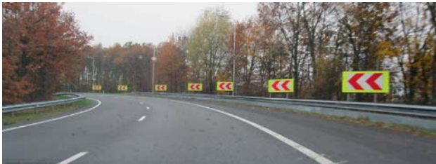
In de "Zeelandboog" zijn reeds bochtschilden met gele fluoriserende achtergrond aangebracht.
