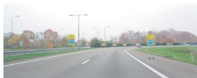
In de "Philip Morris-boog" zijn reeds voorwaarschuwingen en bochtschilden geplaatst.
