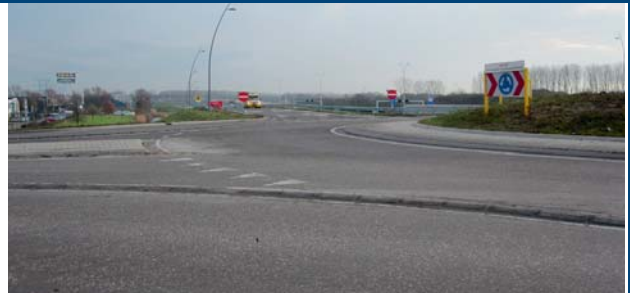
Net voor de rotonde zit er een topboog in de afrit waardoor het zicht op de rotonde voldoende is.
