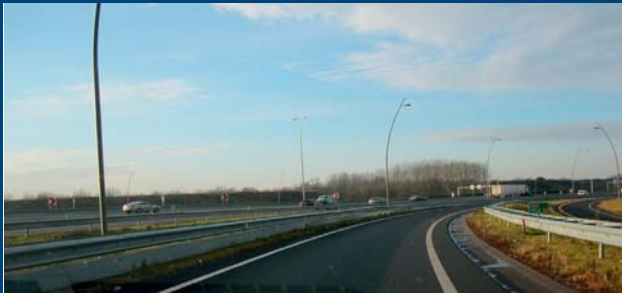
Het wegvak stroomopwaarts van de afrit ligt in een boog waardoor de naderingssnelheid afneemt.
