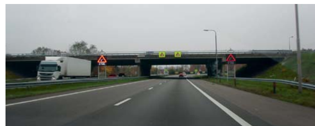
Voor de krappe "Philip Morris-boog" staat een dynamisch snelheidswaarschuwingssysteem.
