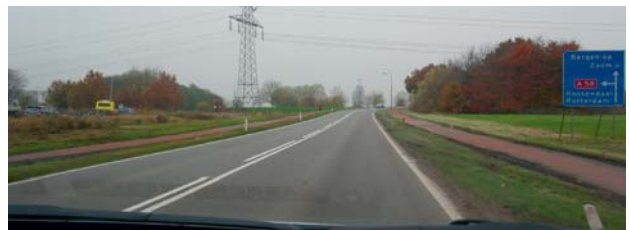
Op de Plantagebaan vanuit zuidelijke richting is voldoende zicht op de toe-/afrit door de helling.
