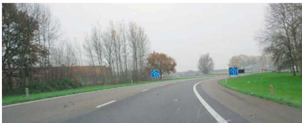
De L-borden in de verbingsboog informeren de weggebruiker over de naderende taper.
