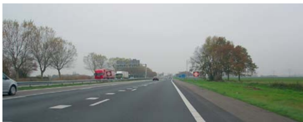
Einde van de taper-samenvoeging van de A17 HRR en de A58 HRR, de invogstrook loopt door.
