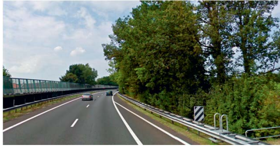
De bocht na afrit Nuth (hm 12,3) waar de vangrail vrijwel direct naast de hoofdrijbaan staat.
