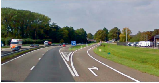
Afrit Spaubeek. Te zien is dat de bocht direct ter hoogte van het puntstuk begint. Daarnaast is er een slecht zicht op de hoofdrijbaan.
