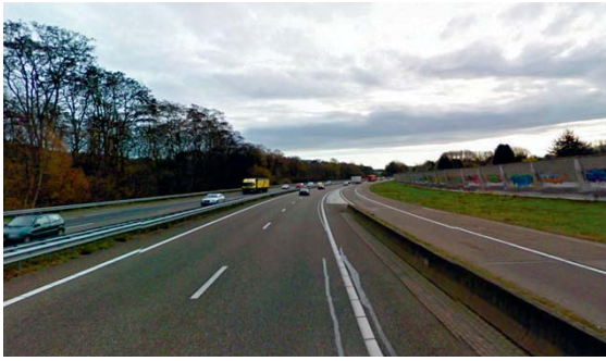
Geluidsscherm ter hoogte van toerit Spaubeek
