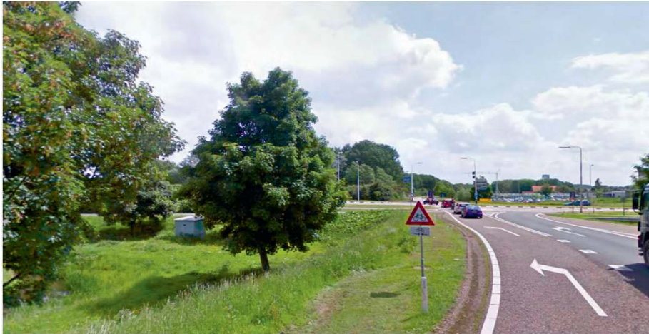
Figuur 1: huidige situatie ter plaatse van de afrit Hendrik Ido Ambacht (A16 HRR). In de linkerzijberm staan diverse bomen welke het zicht ontnemen op het kruisende verkeer. De zichtlijnen zijn pas optimaal ter plaatse van de haaiantanden.
