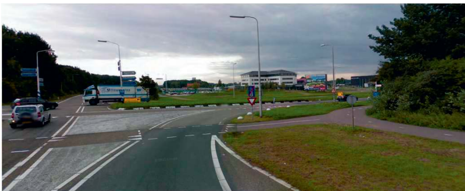
Figuur 2: huidige situatie ter plaatse van de afrit Hendrik Ido Ambacht (A16 HRR). In de rechterzijberm staan diverse bomen welke het zicht ontnemen op het kruisende verkeer. De zichtlijnen zijn pas optimaal ter plaatse van de haaiantanden.
