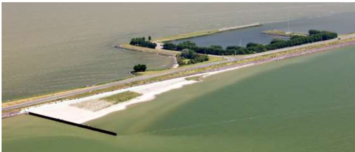
Figuur 1-3 Overzicht proefsectie langs Houtribdijk in juni 2016, twee jaar na de aanleg met ingestelde evenwichtsligging en duidelijk herkenbare vegetatie [bron: opname RWS, Jurriaan Brobbel].
