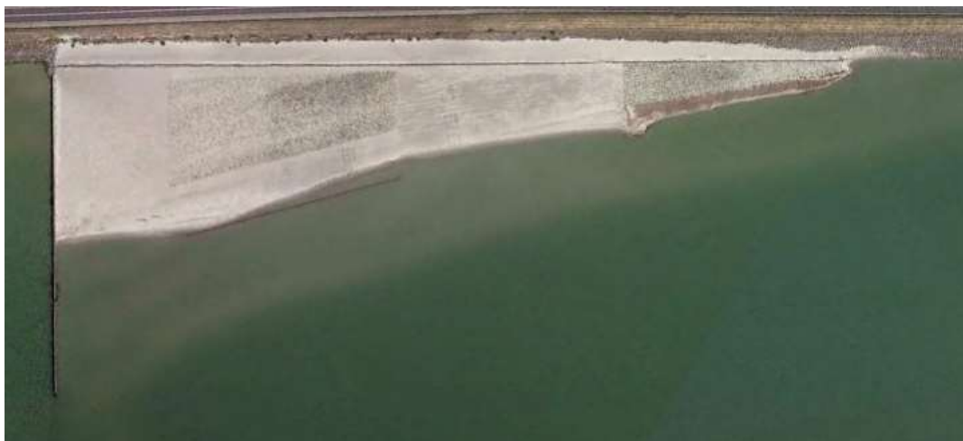
Figuur 1-2 Overzicht proefsectie langs Houtribdijk in juni 2015 na aanbrengen van de vegetatie en een tijdelijke beschermingsdam op het centrale deel van de proefsectie [bron: GoogleEarth-opname 30 juni 2015].
