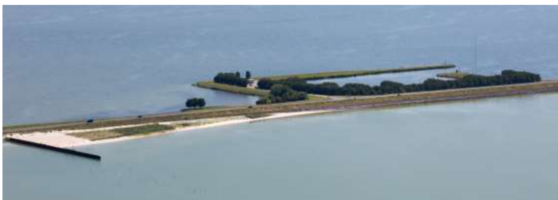
Figuur 1-4 Overzicht proefsectie langs Houtribdijk in juni 2017, drie jaar na de aanleg duidelijk herkenbare vegetatievakken [bron: opname RWS, Jurriaan Brobbel].
