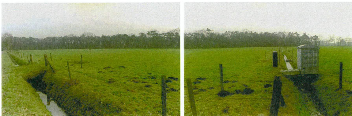
AFBEELDING 2.1 BERMSLOOT (LINKS) EN HAAKS DAAROP DE PERCEELSLOOT (RECHTS) MET DEBIET-MEETOPSTELLING
