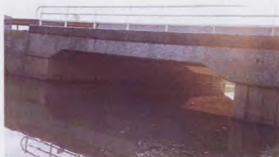
Foto 5.3: Duiker van de Reusel onder de A58
