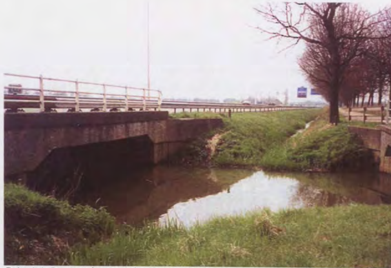
Foto 4.4: Doorsnijding van de Reusel door de A58 (links) en gemeenteweg (rechts).
