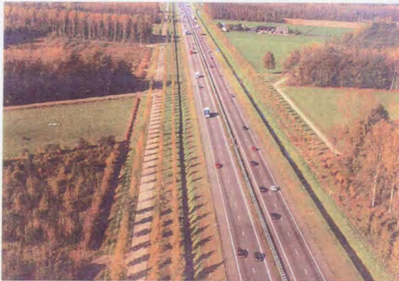
Foto 4.1: Doorsnijding van de Mortelen/Het Groene Woud door de A2 ter hoogte van de Kuppenbunders.
