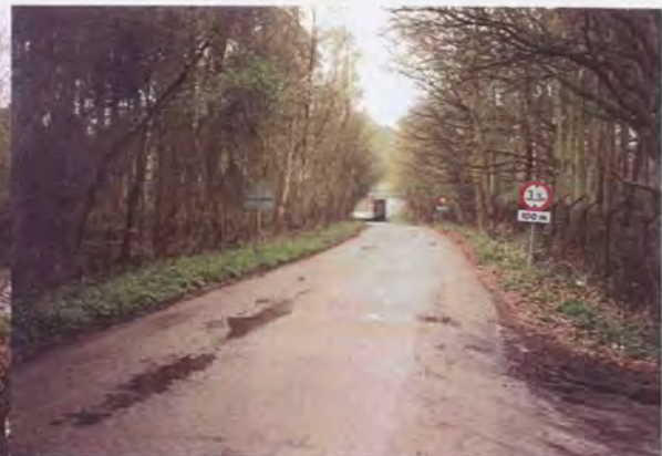
Foto 5.2: Tunnel Meeven aan de oostzijde van de A4.
