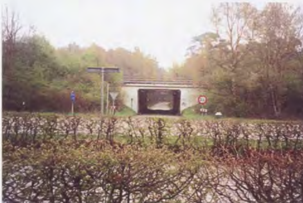
Foto 5.1: Tunnel Meeven aan de westzijde van de A4.
