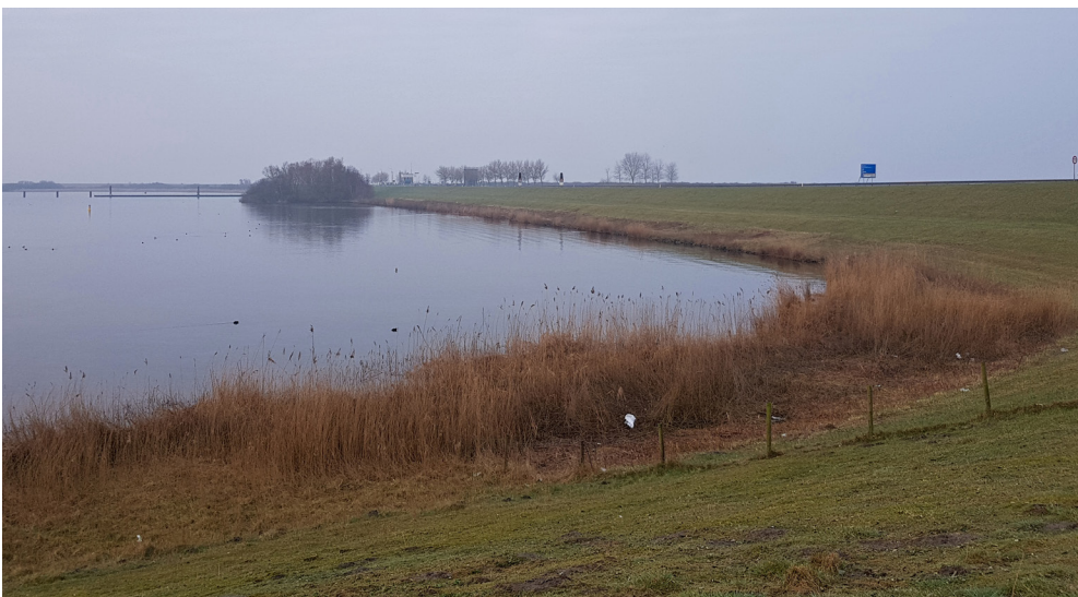
Oever langs de noordkant van het plot, een deel van het riet is in de winter gemaaid. Oesterdam, 25 maart 2018 (fotograaf Maarten Sluijter).
