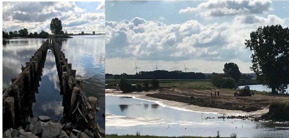
Figuur 5 Foto's van de aanleg van de maatregel (van Michiel Reneerkens).
