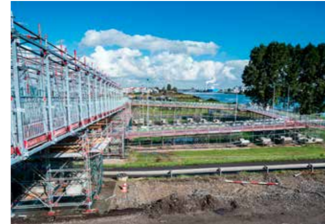
Tijdelijke langzaamverkeerverbinding Botlekbrug, beeld: Rijkswaterstaat
