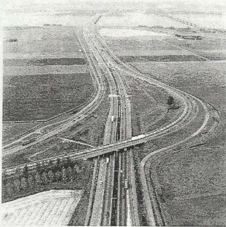
Figuur 5-9 (A16 in noordelijke richting): knooppunt Klaverpolder
