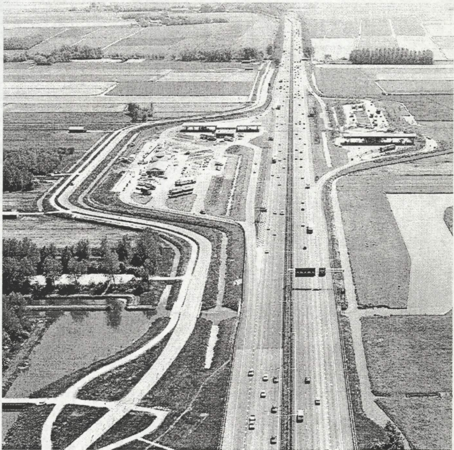
Figuur 5-1 (A13 in zuidelijke richting) :Verzorgingsplaats bij Delft-Zuid,
