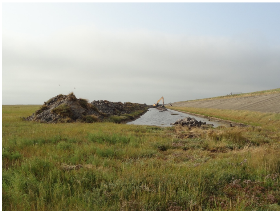
Graafwerkzaamheden op de kwelder ten behoeve van dijkversterking bij De Schorren (augustus 2018)
