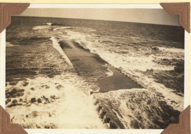
5. Borkum. Hoofd no. VI op Noordzeestrand, aangelegd in 1928 en bestaande uit twee ryen van stalen damwand - afstand 4 M., waartusschen metselwerk op stampbeton. Het hoofd is aan den kop bezonken. Gezien vanaf gemetselde strandmuur in N.N.W.richting.
