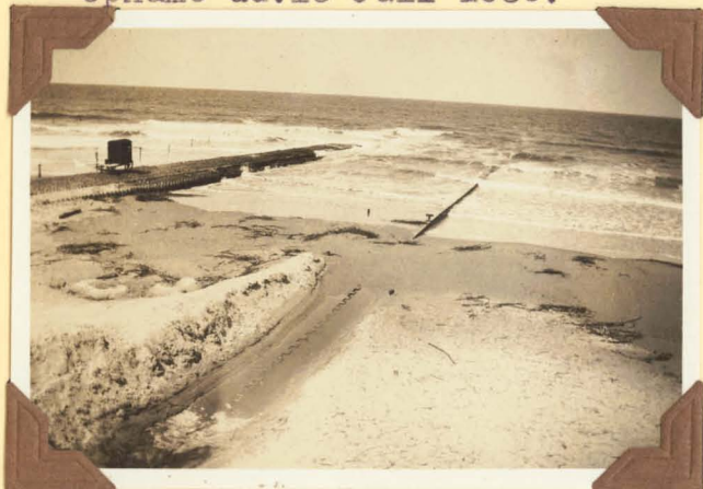
3. Borkum. Hoofd no. II op Noordzeestrand, aangelegd in 1930 en bestaande uit enkele ry stalen damwand, aan den kop bezonken. Op achtergrond bestaande hoofd, hetwelk zal worden afgebroken. Gezien vanaf gemetselde strandmuur in W.N.W.richting.
