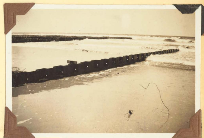
4. Borkum. Hoofd no. II op Noordzeestrand, aangelegd in 1930 en bestaande uit enkele ry stalen damwand, aan den kop bezonken. Op achtergrond, bestaande hoofd, hetwelk zal worden afgebroken. Gezien vanaf het strand in W.richting.
