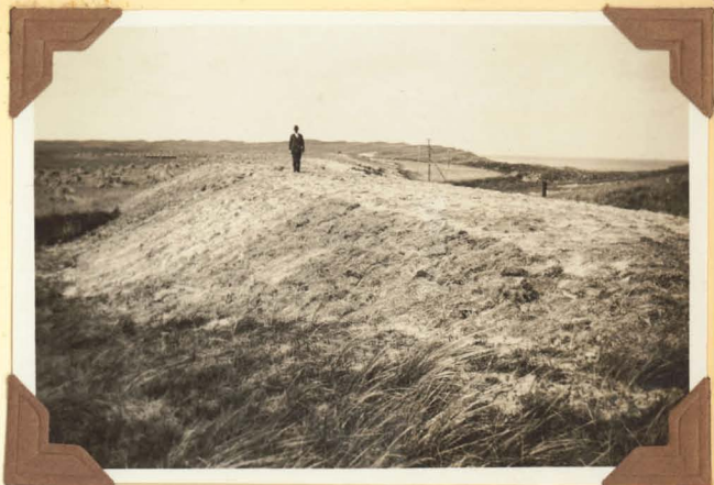
13. Zanddyk in aanleg tusschen de peilraaien VIII en X+50, gezien in N.N. richting, vanaf Zuidelyk uiteinde van dezen dyk. Opname dd. 22 Augustus 1930.
