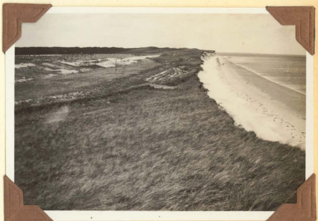
15. Eyerlandsche strand met achterliggende bouwgronden en zanddyk in aanleg, gezien in N.W. richting, vanaf duinrand in peilraai X. Opname dd. 22 Augustus 1930, tydens laagwater.
