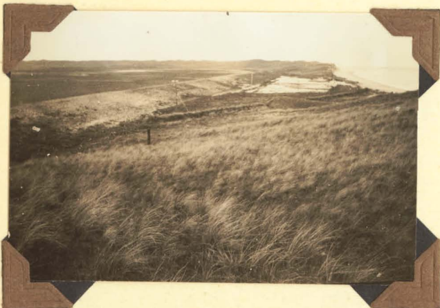
29. Zanddyk tusschen de peilraaien VIII en X met ingeloopen voorland en gedeeltelyk weggeslagen voorgelegen zanddykje, gezien vanaf duin op 40 M. voorby peilraai X.
