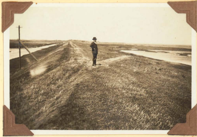
2. Eyerlandsche dyk, Gezien in Noordelyke richting vanaf punt, waar Zuidoostelyke dyk van ingeloopen polder Volharding op Eyerlandschen Dyk aansluit. Opname dd. 22 Augustus 1930.
