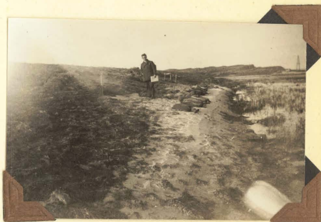
33. Aangetast buitentalud in peil-raai Xa van zanddyk tusschen de peilraaien VIII en X, gezien vanaf teen van den dyk in N.N.W. richting.
