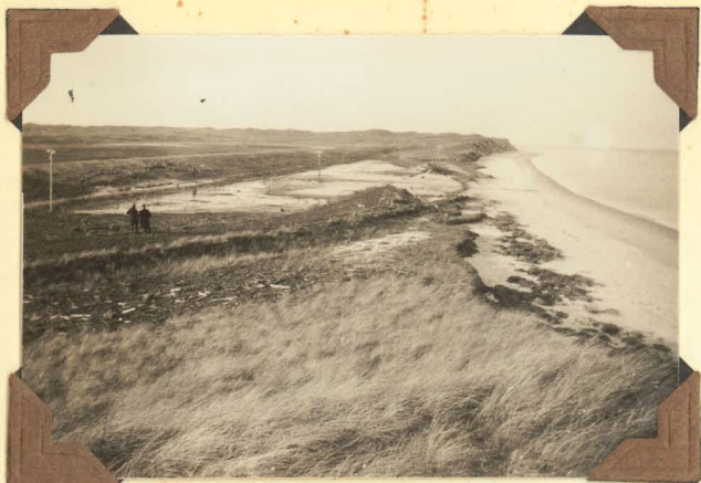
30. Zanddyk tusschen de peilraaien VIII en X met ingelooopen voorland en gedeeltelyk weggeslagen voor-gelegen zanddykje, gezien in N.W. richting vanaf duinrand in peil-raai X.
