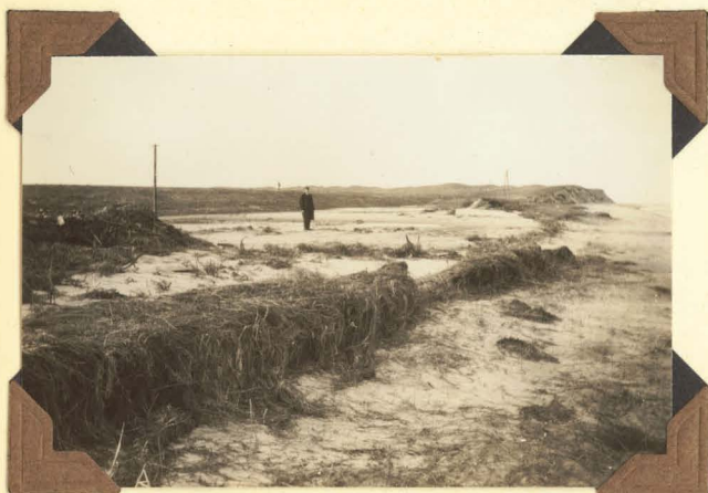
32. Weggeslagen zanddykje tusschen de peilraaien IX en X, gezien in N.W. richting vanaf duinvoet op achtergrond zanddyk tusschen de peilraaien VIII en X.
