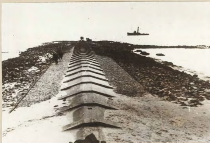
+ figuur 26. Voormalige betondam van het vaste punt "de Stuifdijk" op Texel. +
