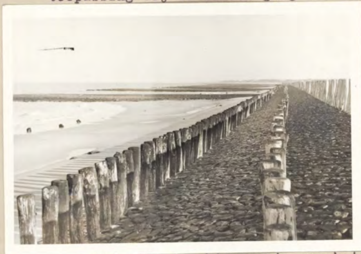
+ figuur 38. Hondsbossche zeekering; strandhoofdenverdediging met kunstmatige vooruitgeschoven waterkering. +
