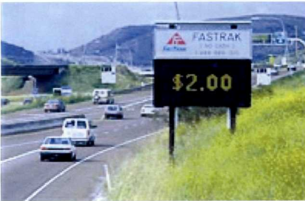
Figuur 14 Dynamisch tolpaneel
