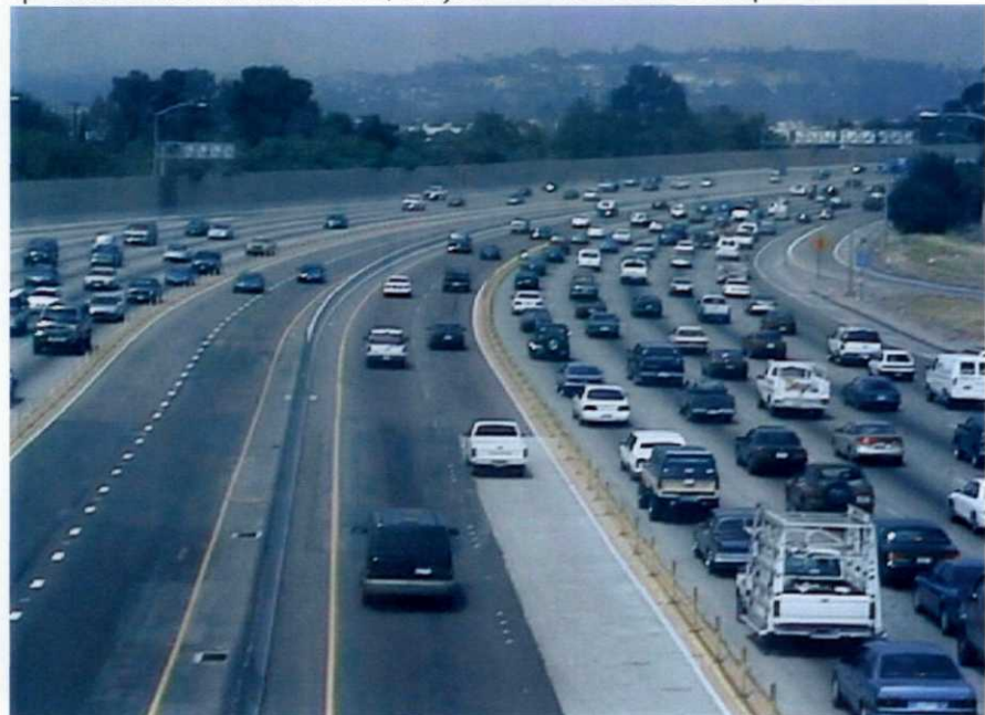
Figuur 22 Overzicht 91 Express Lanes
