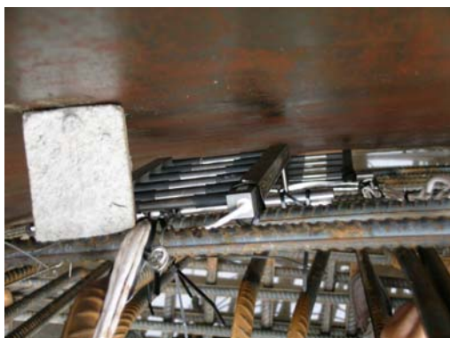
Figuur 2. Ingebouwde anodeleadder klaar om ingestort te worden
