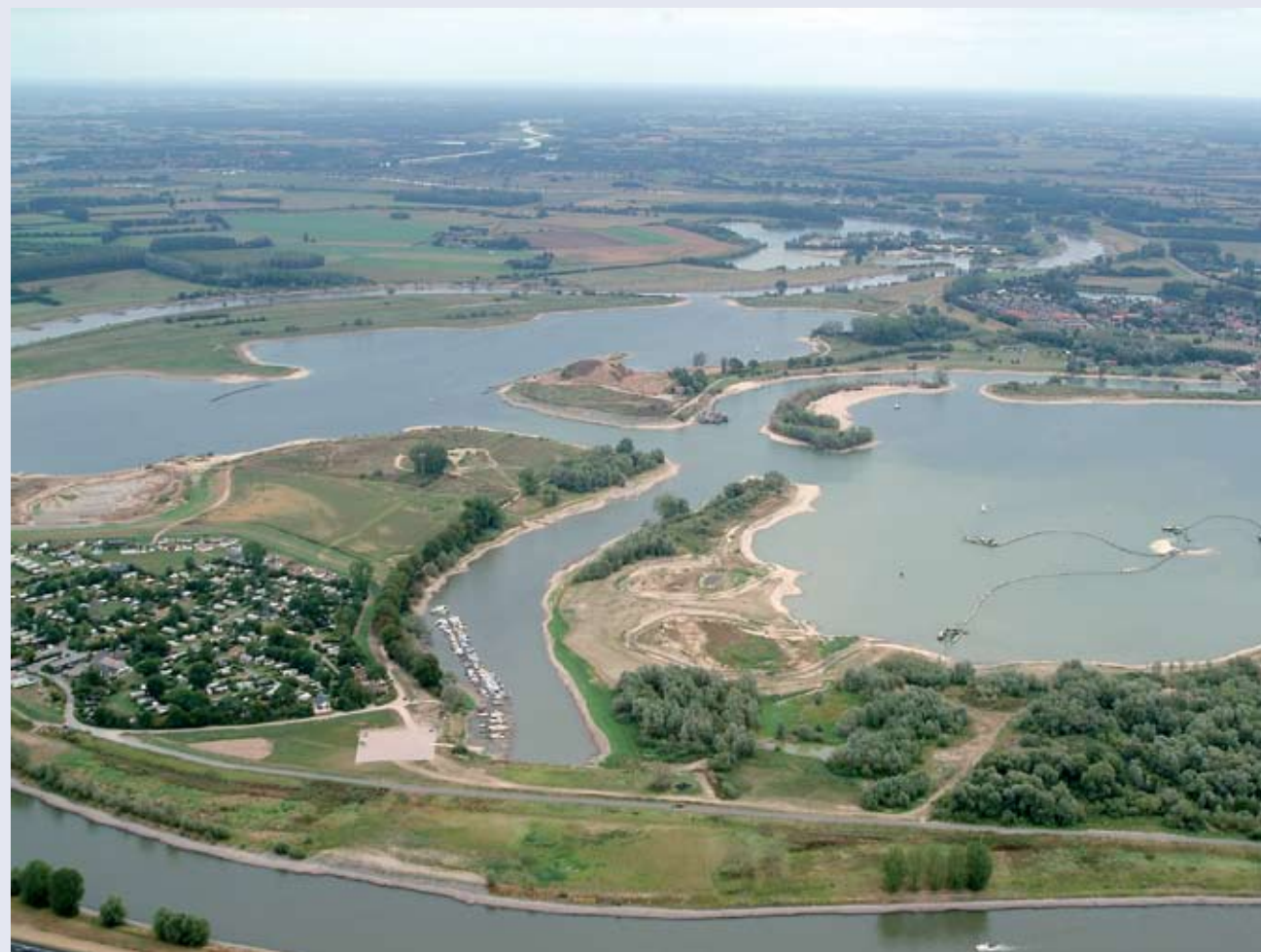
Diepe zandwinning langs de IJssel bij Giesbeek.
