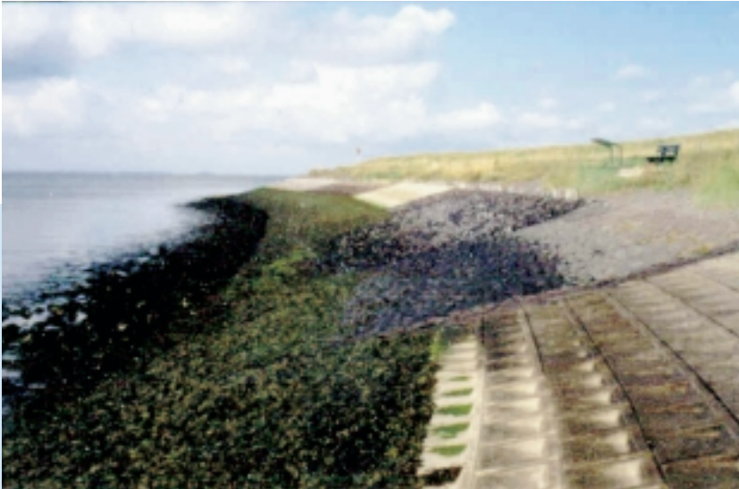
Experiment 'Dijkstuin 2': het laat zien dat de begroeiing op de dijkglooing per oeverbekledingssoort varieert.
