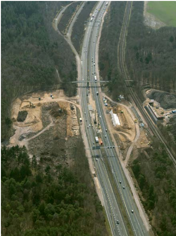
Natuurverbinding Zwaluwenberg in aanleg. (foto: Rijkswaterstaat)
