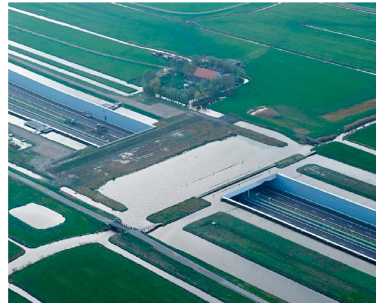
Eco-Aqueduct Zweth en Slinksloot. (foto: www.iods.nl )
