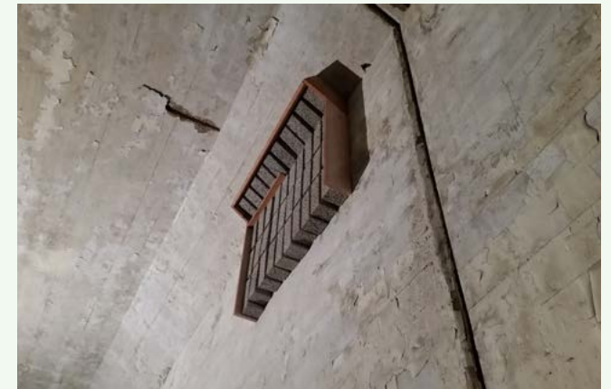
Vleermuisschuilplaats in tunnel onder A12. (foto: Victor Loehr – RWS)
